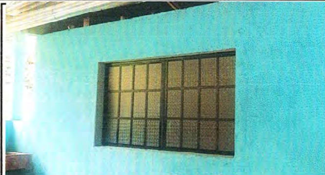
Foto 2: Ventana de la cocina culminada.
