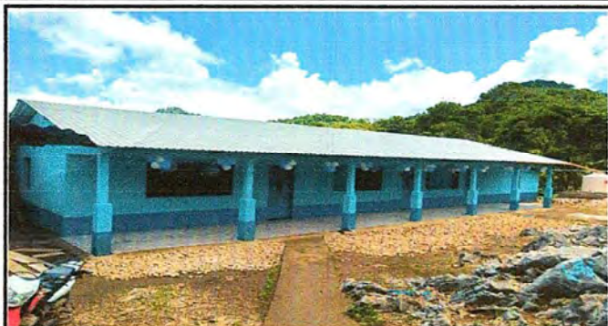
Foto1: Tres ventanas colocadas en su totalidad y la pintada del edificio escolar tanto dentro y fuera.
