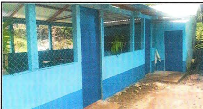
Foto 3: Culminada la colocacion de las tres puertas.
